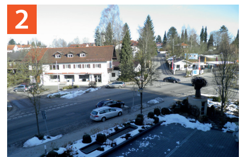
Kreuzungsbereich Hausergasse/Forstenrieder Weg/ Hermann-Roth-Straße/Rad- und Fußweg
